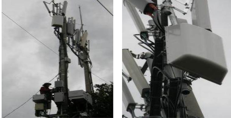
[그림 6-5] 전망대에서의 TV 유휴대역 AP 장비 설치
