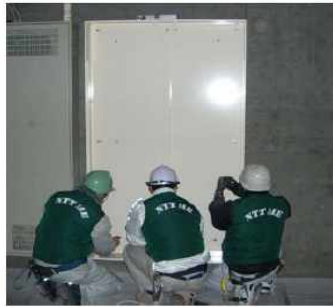
標準19インチラックが置けない場所に 薄型盤(厚さ200mm)を設置。光設備構 築を可能にした。
