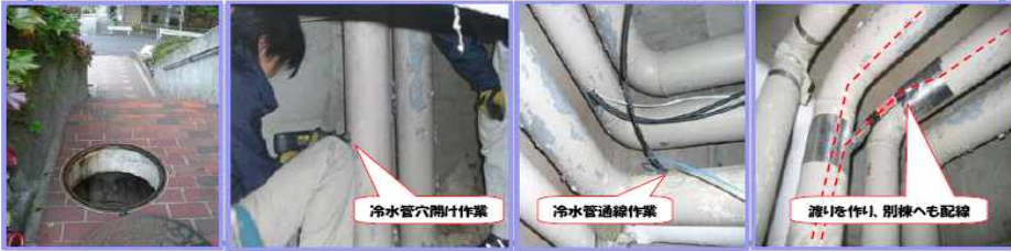
地下ピット内の通線工事の様子
